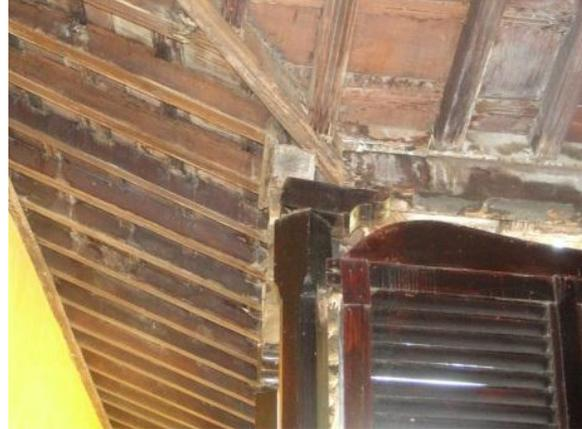
Sin embargo a nivel puntual el deterioro se da a nivel mecánico o estético a causa de la presencia de xilófagos y termitas en las áreas perimetrales al mirador y en algunas zonas por la presencia de filtraciones a causa de fallas en el sistema de impermeabilización acentuándose el deterioro en los enrasos de las cumbres contra muros, en los remates contra estos, así como en las limahoyas.
