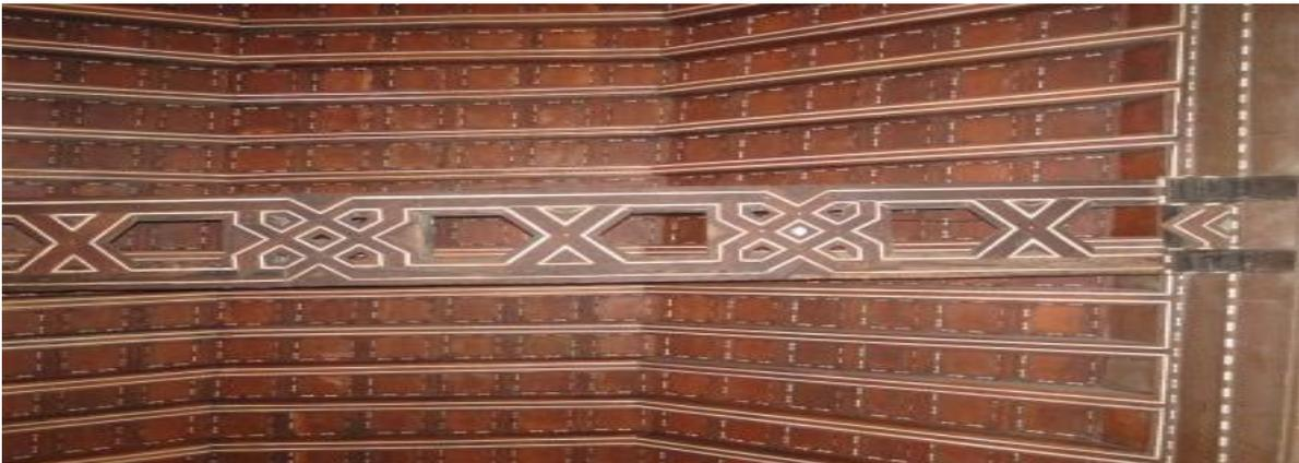
Este sistema construido en maderas recias, presenta además del sobre par, elementos de soporte como son soleras, sobre soleras, estribos y ménsulas, conformando una artesa con lacería y tirantes compuestos. La estructura de cubierta es estable gracias a las secciones de sus elementos.
