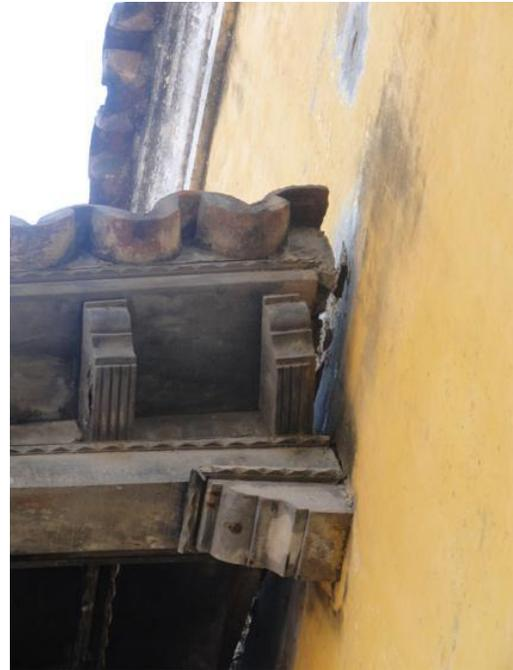
La madera evidencia pudrición parcial en los elementos comprometidos en partes medias y en las cabezas de las vigas, así como presencia de xilófagos en un alto porcentaje de los maderos de las zonas con este sistema.
